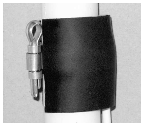
Izolace čidla termo- izolační páskou
